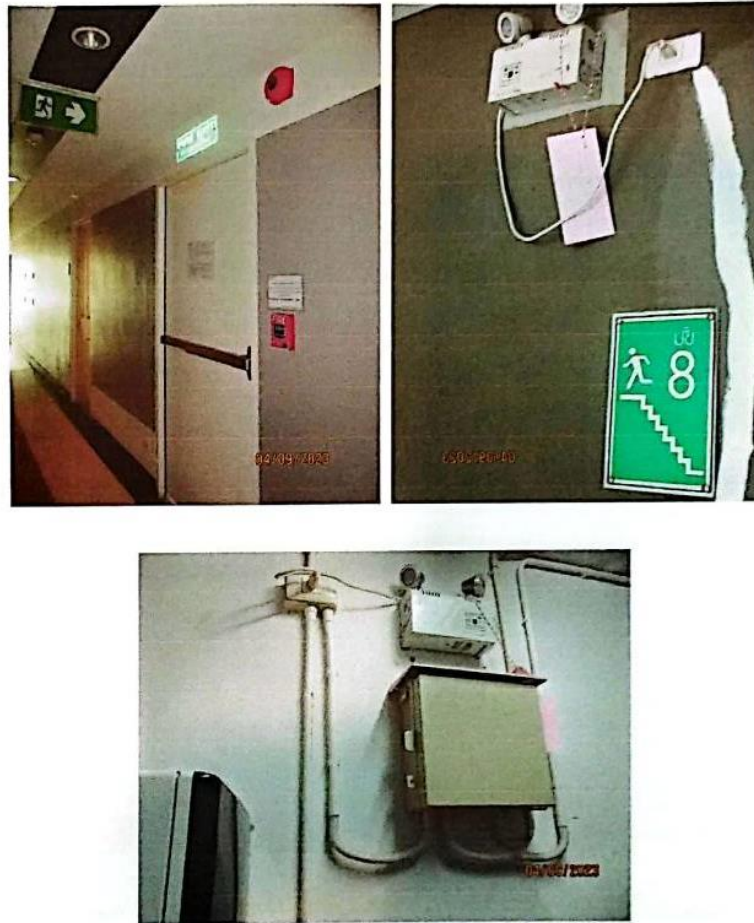
รูปที่ 3 แสดงอุปกรณ์แจ้งเตือนด้วยมือ อุปกรณ์ส่งสัญญาณเสียง ไฟส่องสว่างฉุกเฉินและป้ายบอกทางหนีไฟ ข้อตรวจพบ อุปกรณ์แจ้งเตือนด้วยมือ, อุปกรณ์ส่งสัญญาณเสียง, อุปกรณ์ส่องสว่างฉุกเฉินและป้ายบอกทางหนีไฟ พร้อมใช้งาน
